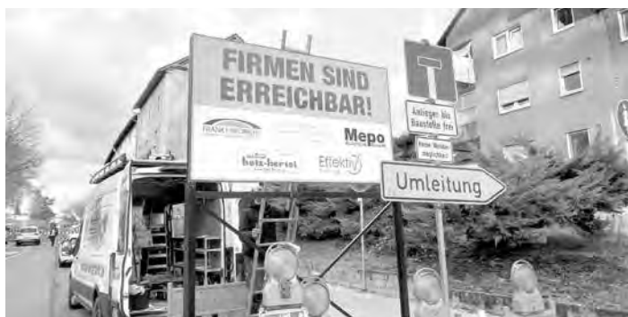
Die Firmen im Industriegebiet sind trotz Baumaßnahme weiterhin erreichbar. Foto: Agentur exakt
